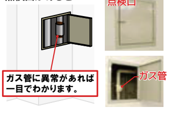
柱(壁)の中をガス管が通っている場合があります。
